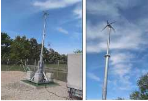
Слика 5. Ветрогенератор на преклопном стубу у радном положају
